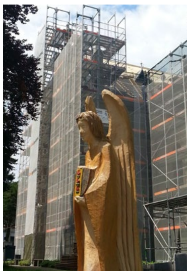
Kirche Wetzikon im Gerüst
